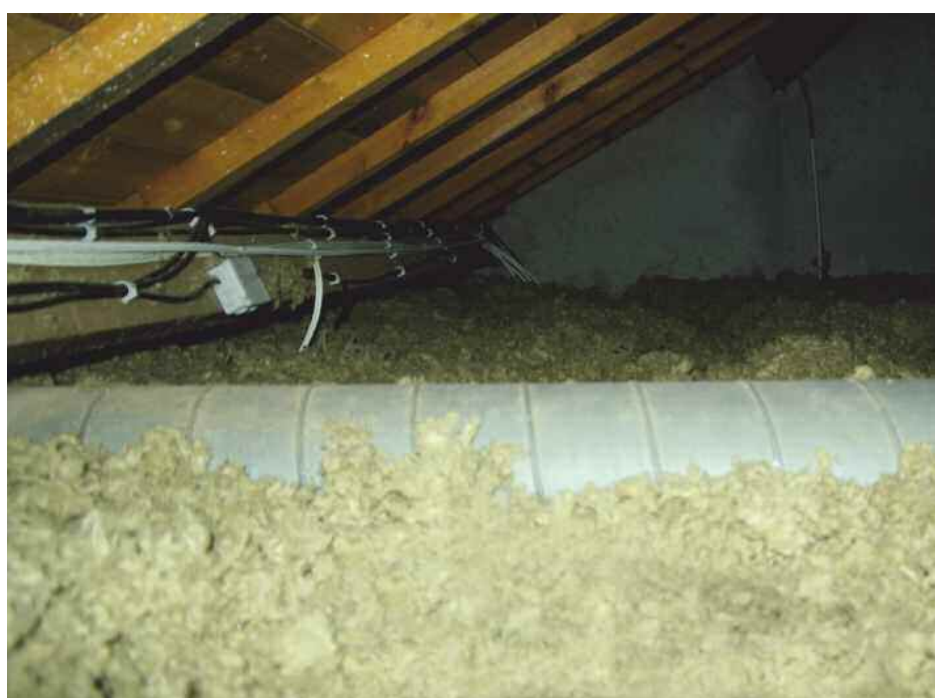
Soufflage de laine de roche dans les combles des résidences
